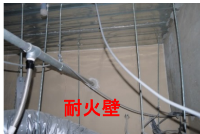
耐火壁（天井内）
