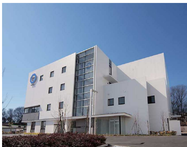
東京試験所外観
